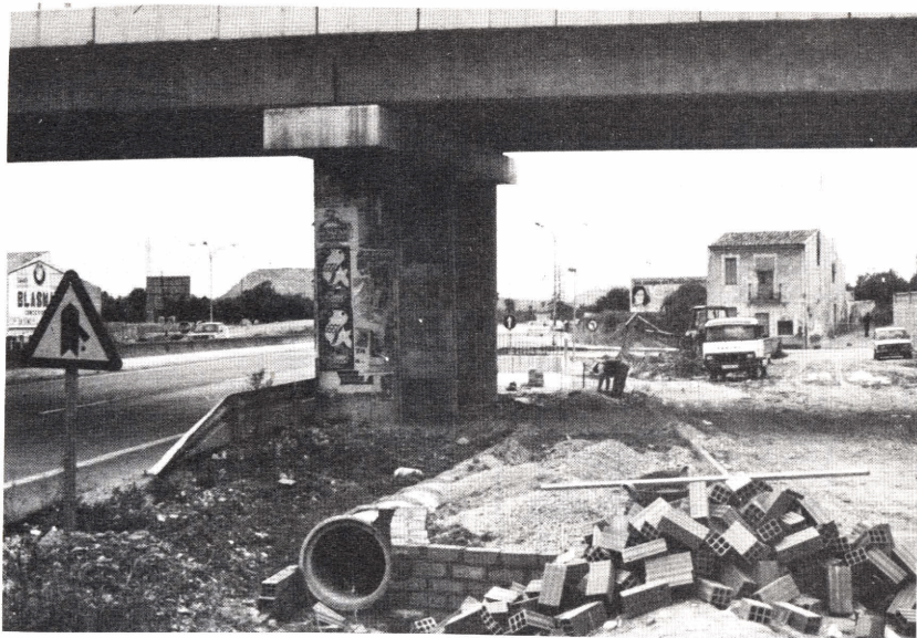
Mejora en los accesos a Benimagrell por el paso subterráneo.
