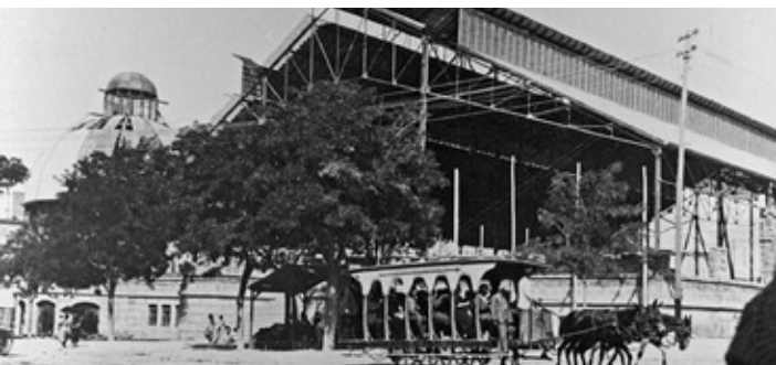
Mercat Central d'Alacant en construcció inaugurat a l'any 1922 8 . Tracció animal amb carruatge tipus "jardinera"
