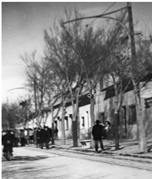
Carrera de motos a la Rambla el dia 25-12-1959 on s'observa perfectament la via i catenària
